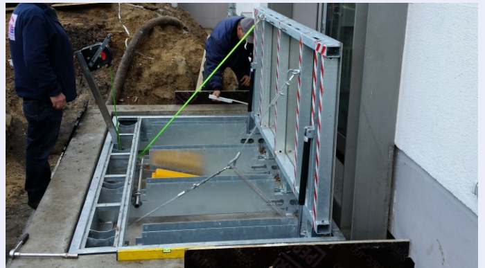
Einbau eines Klappschotts
