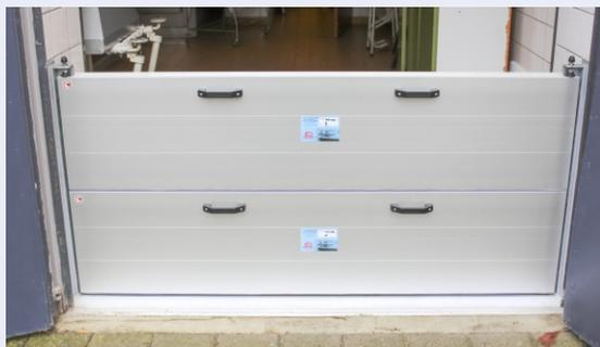
Modul STANDARD- 2 Modulbauplatten
