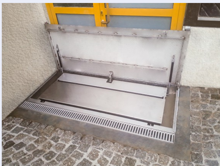
CHT-MINI Klappschott in Hochwasserschutzposition
