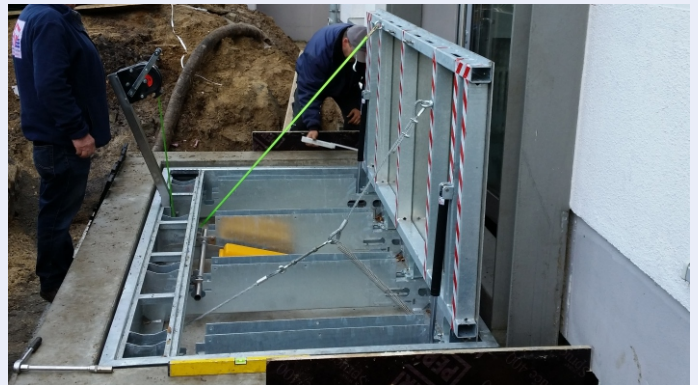
Einbau eines Klappschotts
